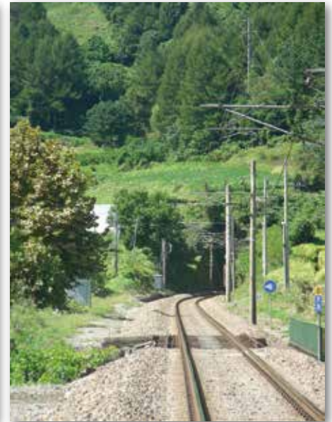
Le tunnel côté Ouest
