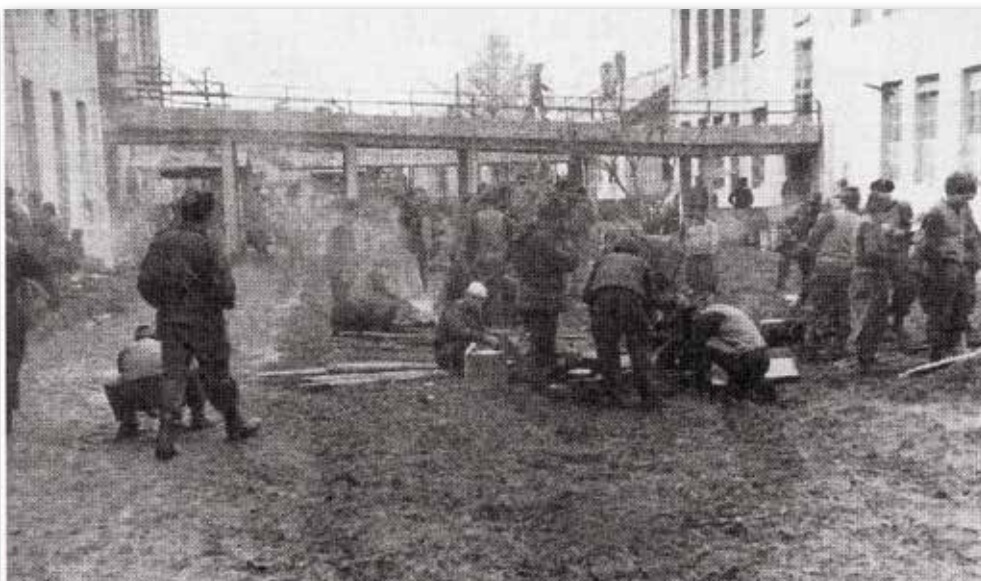
Le bataillon s'installe dans l'école d'agriculture de SUWON fortement endommagée (Photo Gérard JOURNET)
