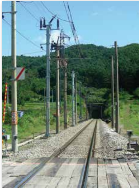
Le tunnel côté Est
